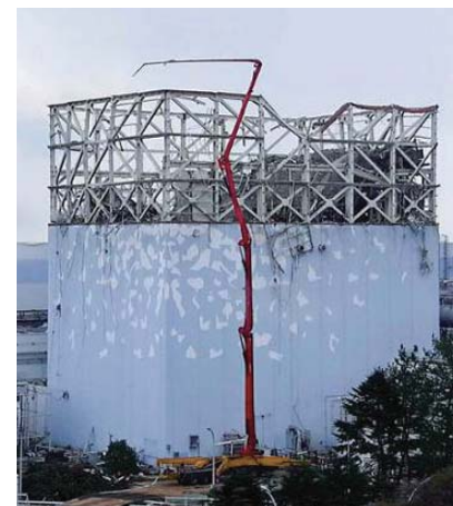
建屋外から注水するコンクリートポンプ車 (福島第一原子力発電所1号機)
