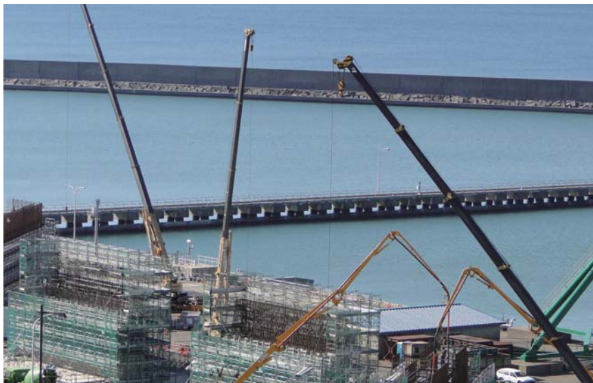
建設中の1~4号機側防潮堤(2012年12月撮影)
