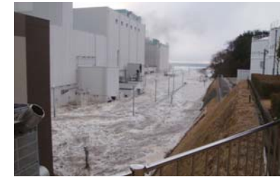
福島第二原子力発電所1号機の原子炉建屋脇を遡る津波
