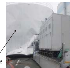
漂流し、道を塞いだ重油タンク
