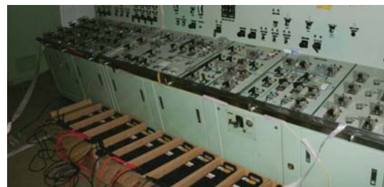
集めたバッテリーが計器等に接続されている様子 (福島第一原子力発電所1/2号機中央制御室 2011年3月23日撮影)
