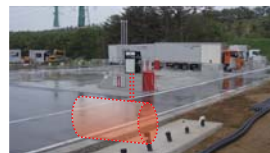
高台地下軽油タンク
