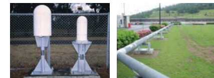
モニタリングポスト 地上化した消火系配管 (新潟県中越沖地震に伴う対策)
