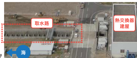
取水路開口部への蓋掛け
