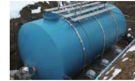
新潟県中越沖地震後に設置された防火水槽
