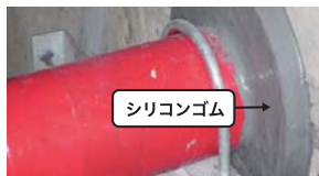
配管貫通部の止水処理施工例(施工後)
