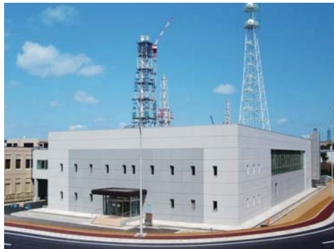
免震重要棟(写真は現在運用中のもの)
