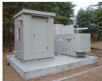
モニタリングポスト用ディーゼル発電機
