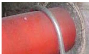
配管貫通部の止水処理施工例(施工前)
