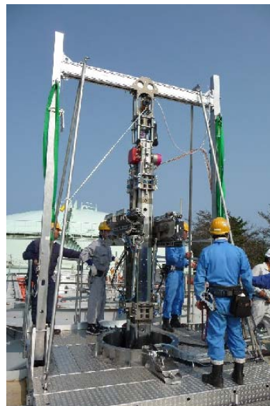
タンク底部フランジ補修作業の トレーニングの様子
