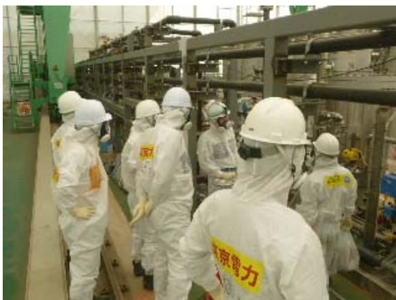
高性能多核種除去設備設置作業における 現場作業員への助言・指導の様子
