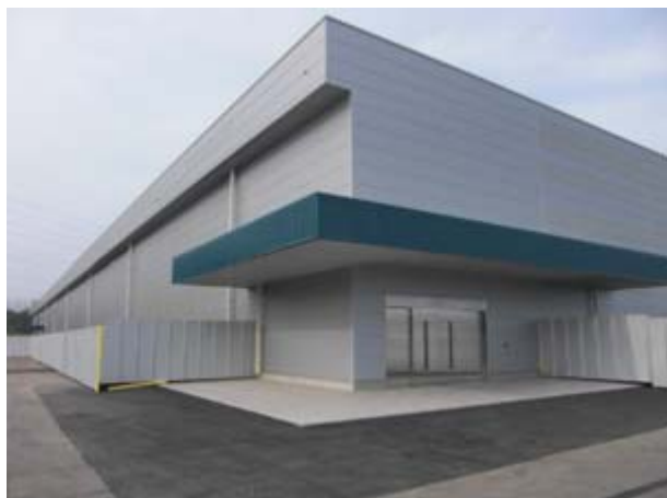
新事務棟外観
