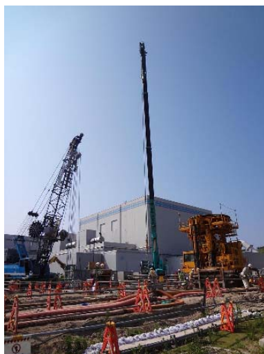
1～4号機側における立坑調査作業
