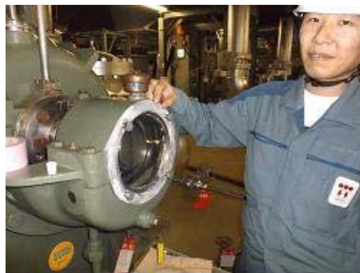
被水したポンプの復旧手順確立（福島第二） （被水模擬のための仮カバー（透明）を取付けた様子）
