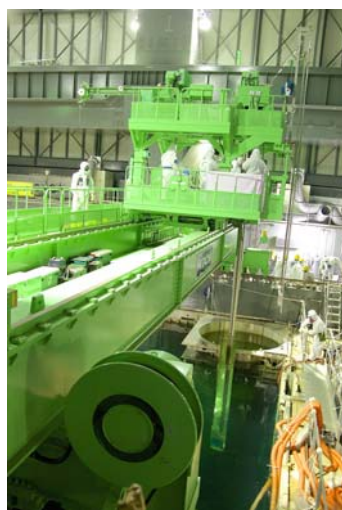
燃料取り出し状況
