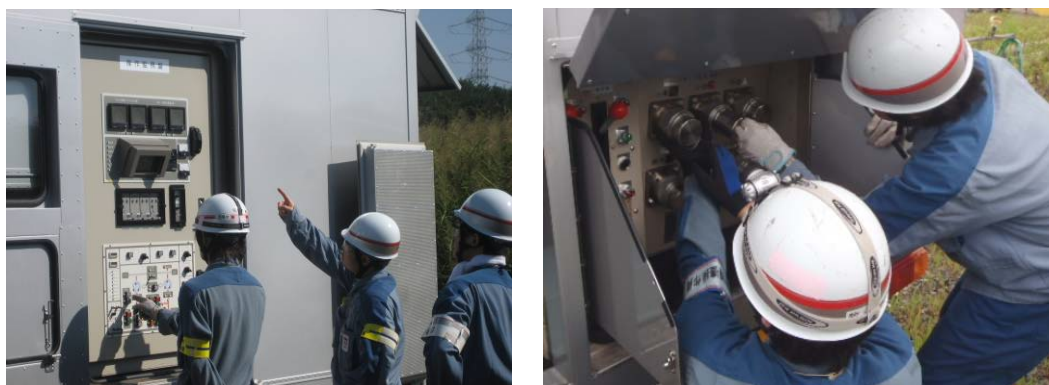
電源車起動訓練の様子（左：運転状態の確認、右：端子カバーの取り外し）
