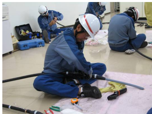
高圧ケーブル端末処理訓練
