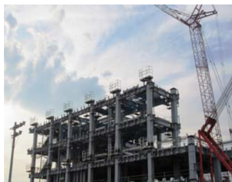
建設中の構内大型休憩所
