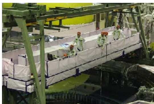
原子炉内構造物点検の様子 (原子炉内への水中カメラの吊り下ろし)
