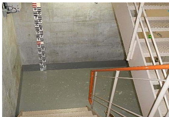
浸水状況把握用の簡易メジャー取付け（柏崎刈羽） （建屋最地下階へ設置した浸水水位計）
