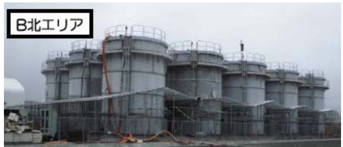
堰カバー（屋根材）設置状況
