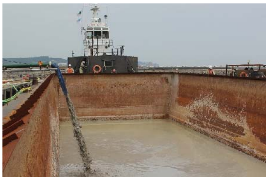
被覆材の船への積み込み作業
