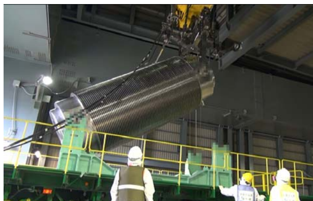
構内用輸送容器のトレーラへの積込み
