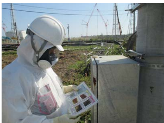
錆限度見本の電気設備への活用（福島第一） （巡視パトロールの様子）
