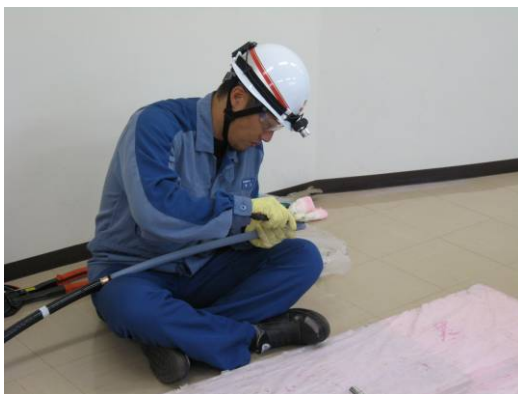
高圧ケーブル端末処理訓練
