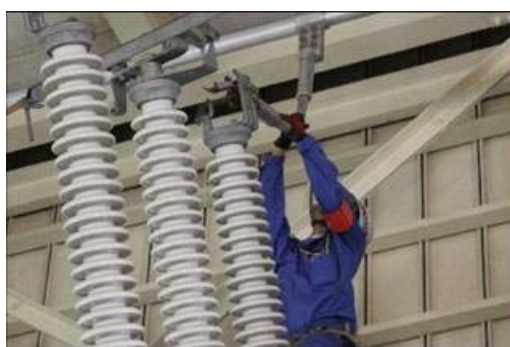
6万6千ボルト電源供給回線点検の様子
