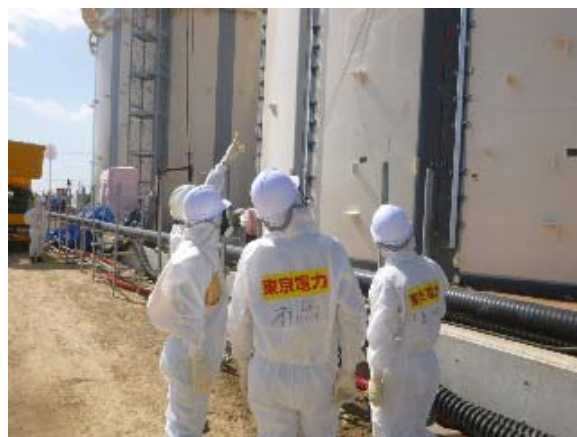
J4 エリアにてタンク設置作業状況を 確認している様子
