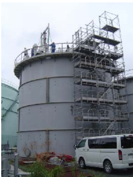
確認試験を行っているフランジ型タンク
