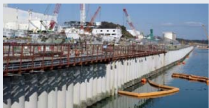
海側遮水壁閉合の完了
