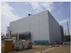
雑固体廃棄物焼却設備外観
