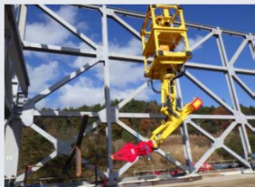
1号機 支障鉄骨除去装置の操作訓練の開始 (広野町に設置した訓練施設)
