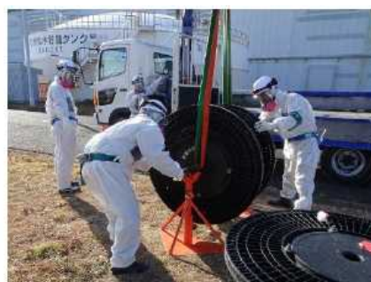
ケーブルドラムの積み下ろし
