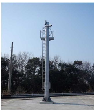
高台駐車場への感知器設置
