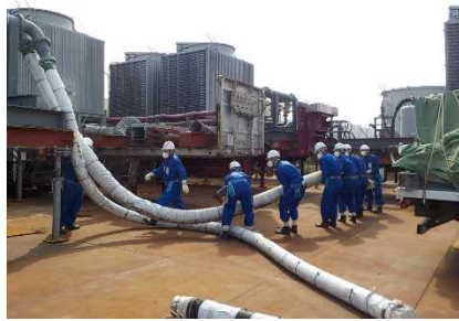
使用済燃料プール注水設備の接続訓練の実施（福島第一） （写真左は空冷ユニット）
