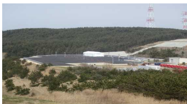
大湊側高台駐車場の整備（舗装箇所）
