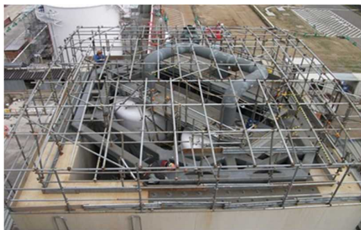
よう素フィルタ周りの配管布設状況 (7号機)
