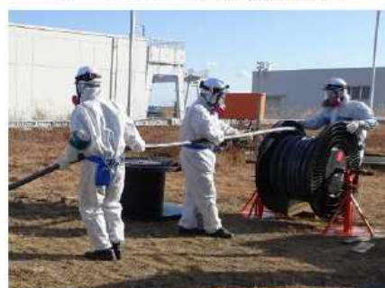
ケーブル敷設
