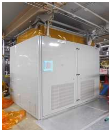
追設した所内電気設備用変圧器と配電盤(7号機)
