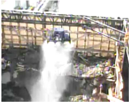
飛散防止剤散布作業
