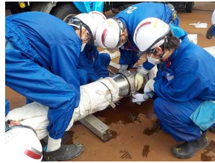
使用済燃料プール注水設備の接続訓練の実施（福島第一） （写真左は空冷ユニット）
