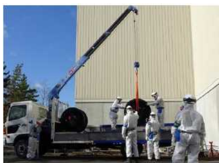
玉掛け合図者の合図による ケーブルドラムの積み込み
