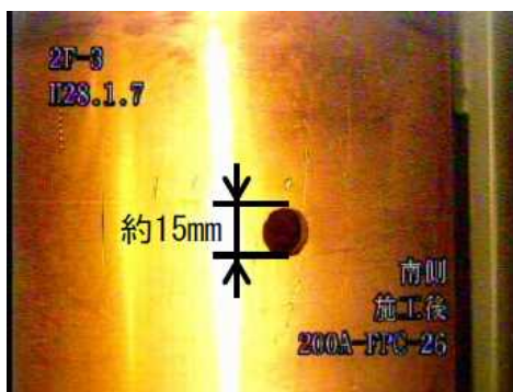
加工（穴開け）後の配管（3号機）
