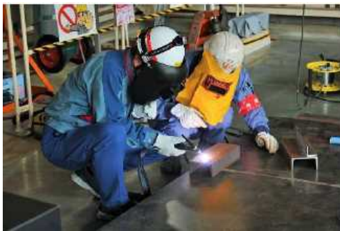
講師指導のもと鋼材を溶接
