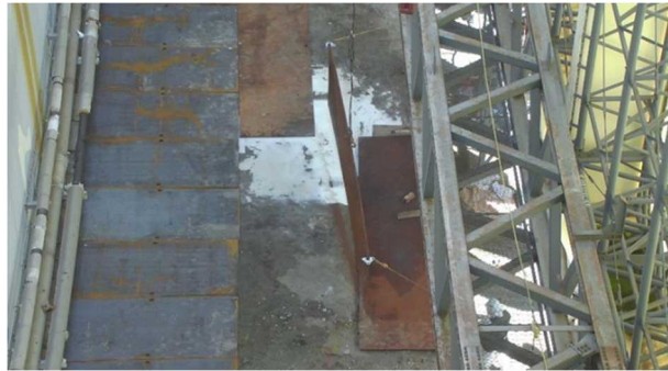
散水ノズルまでの配管設置に向けた敷鉄板整備状況
