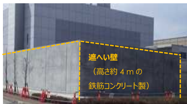
免震重要棟の遮へい壁
