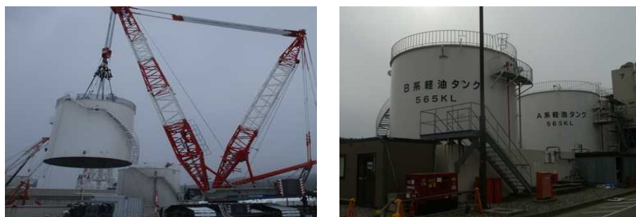
軽油タンクの取り替え（7号機）（左：タンク吊込時、右奥：設置後）
