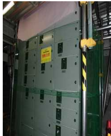
追設した所内電気設備用変圧器と配電盤(7号機)
