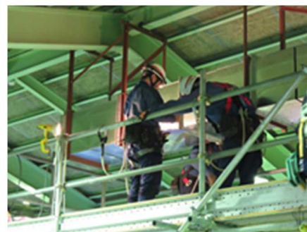
空調設備のダクト修理訓練の実施（柏崎刈羽） （左：材料加工、右：高所でのダクト補修作業）
