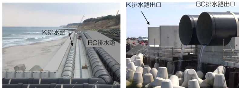
付け替え後のK排水路出口
