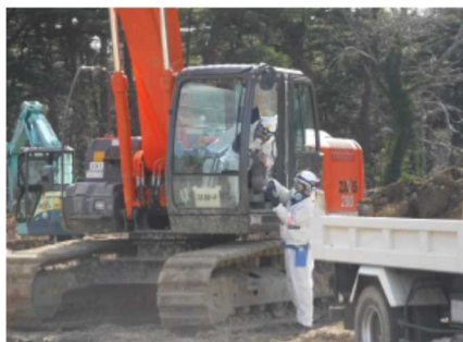
全面マスク装着状態での瓦礫撤去、仮設ケーブル接続訓練の実施（福島第二）
