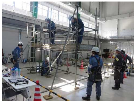
足場組立・解体訓練
