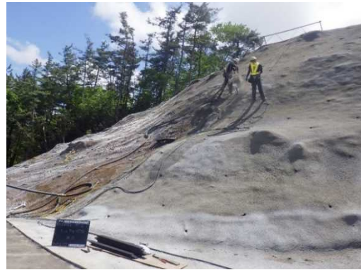
モルタル吹付
