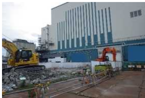
大物搬入口解体
