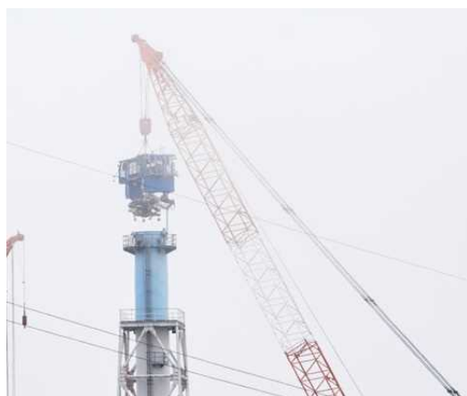
排気筒最頂部への設置確認作業
