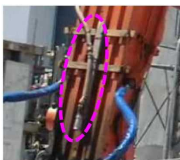
カイゼン後：重機先端に自動散水用ホースを設置
