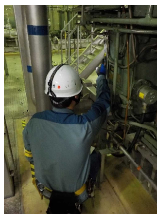
油漏えいリスク低減のための潤滑油タンク給油手順の変更（柏崎刈羽） 左：タンク補給弁の開操作 右：タンク給油レベルの確認
