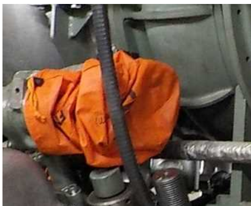
配管養生用カバー
