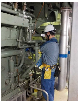
油漏えいリスク低減のための潤滑油タンク給油手順の変更（柏崎刈羽） 左：タンク補給弁の開操作 右：タンク給油レベルの確認
