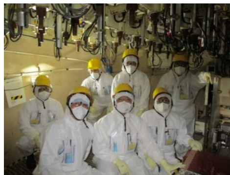
5号機原子炉圧力容器下部
