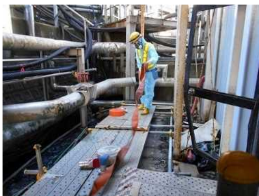
ホース敷設（原子炉注水設備破損時対応訓練）
