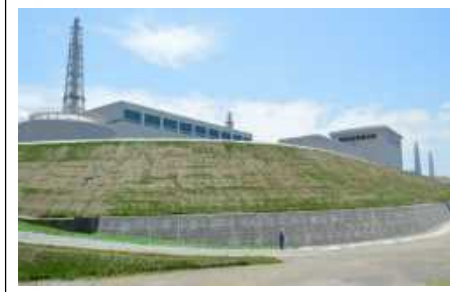
防潮堤(5~7号機側)
